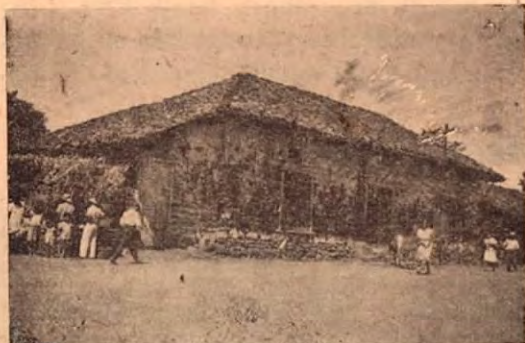
Casa centenaria de Nicoya fué destruída por hallarse en estado ruinoso
